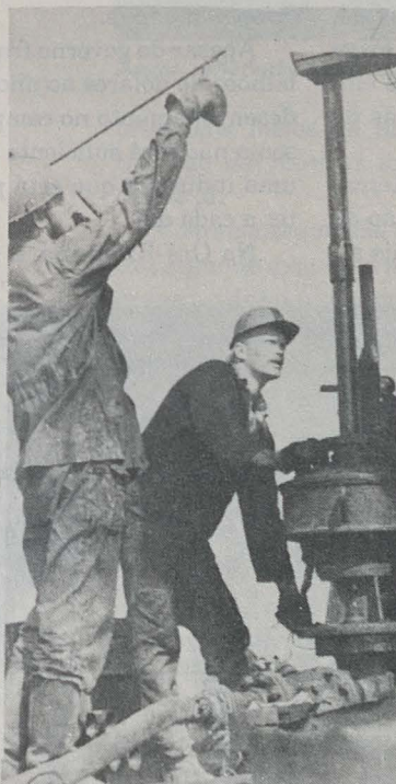
Fábricas: em fase de reestruturação
