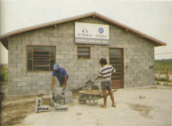
Construcción de habitaciones por el sistema TRAVA-BLOCOS - Brasil
