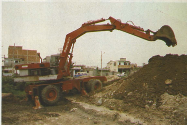
Obras de saneamiento básico - (Brasil)
