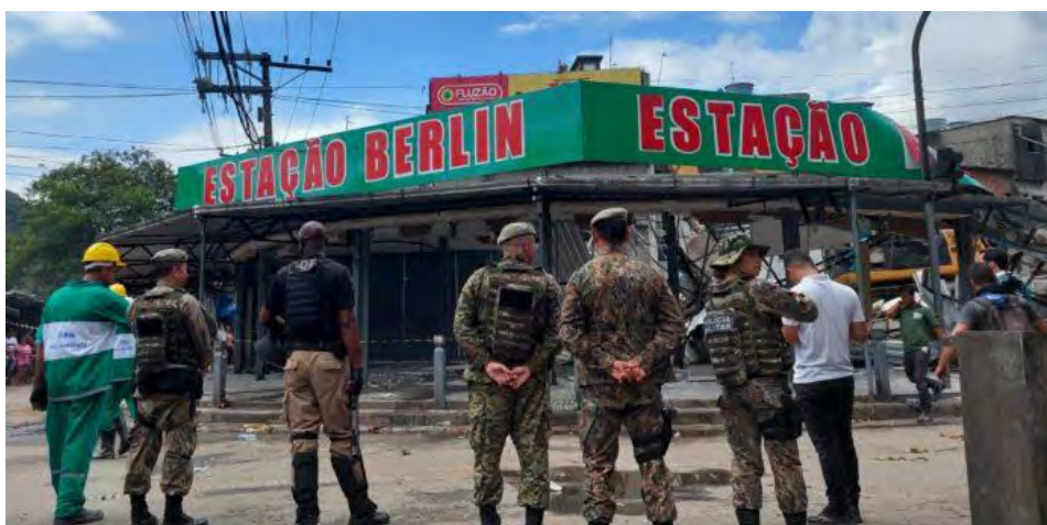
Imagens 27, 28, 29 e 30: Demolição do Estação Berlin 40
