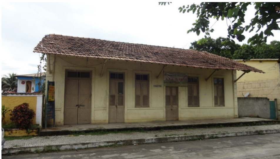
Figura 46: Antiga estação ferroviária em Vila do Tingúá, nas proximidades da praça central
