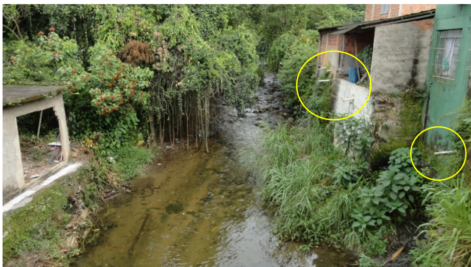
Figura 68: Indicativo de possível esgoto que é lançado em curso hídrico – Vila do Tinguá Fonte: Acervo AUTOR (2020)
