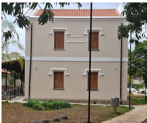
Figura 30. Estação Ferroviária de Chiador
