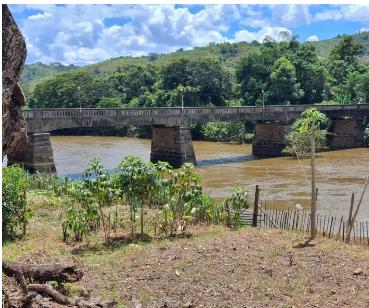
Figura 50. Ponte na RJ 151
