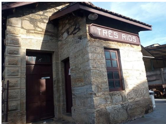
Figura 40. Casa de Pedra
