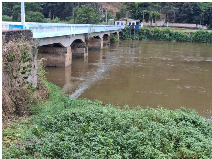
Figura 38. Ponte sobre o rio Paraibuna
